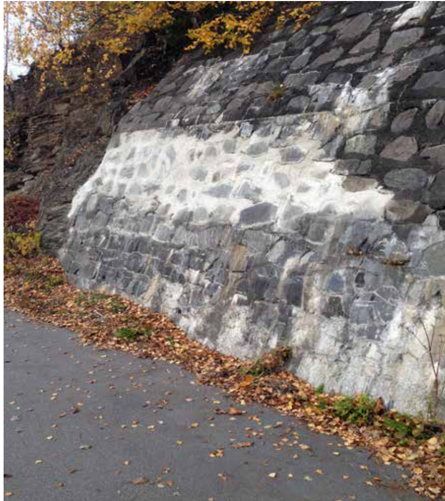
Den reparerte støttmuren
