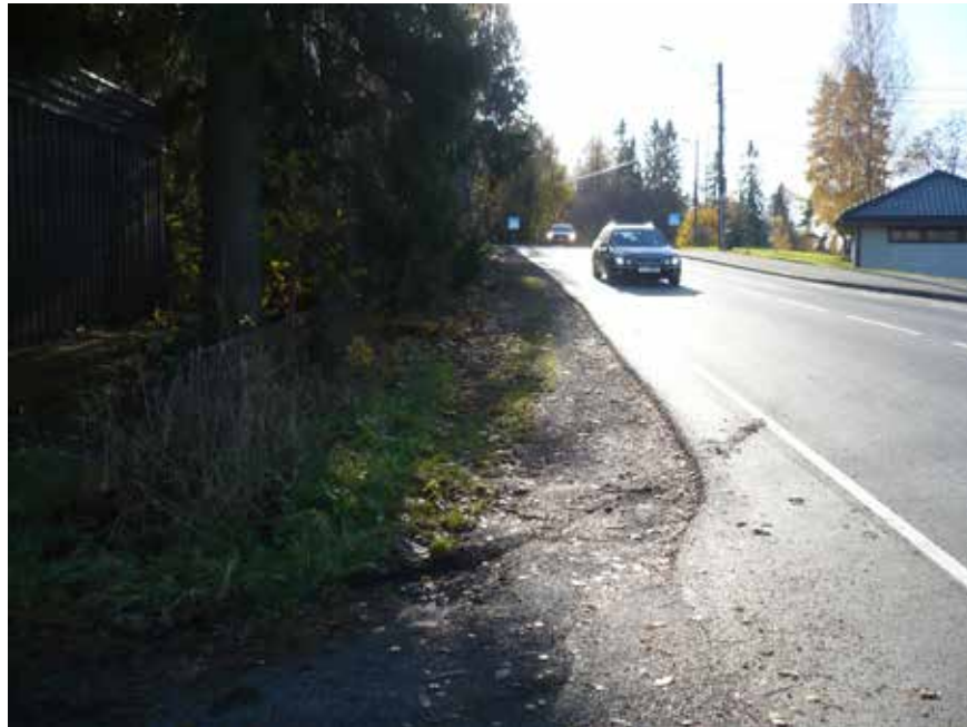
Nadderudveien på strekningen Liomveien – Liomåsen bussholdeplass
